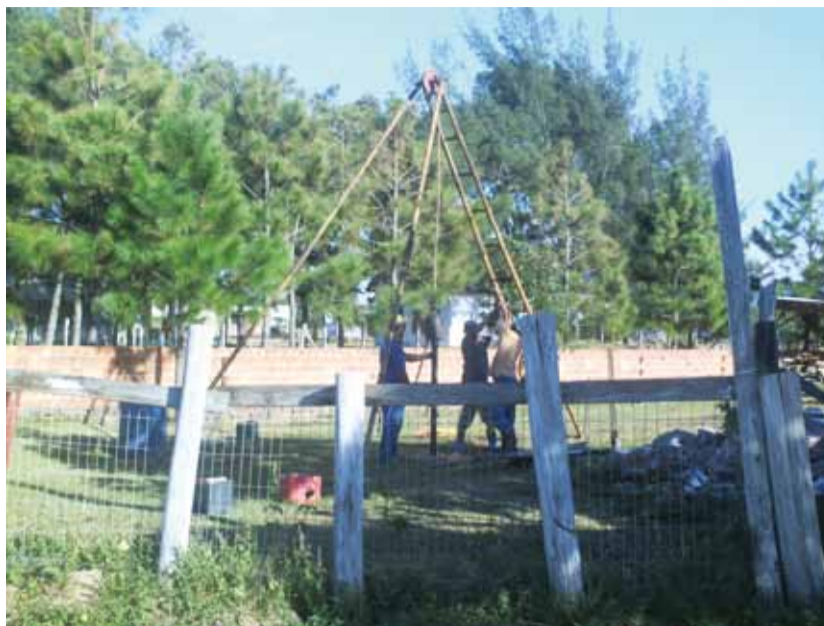
Obras de estaqueamento
