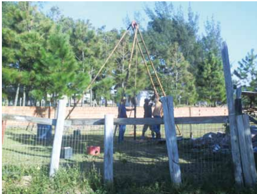
Obras de estaqueamento
