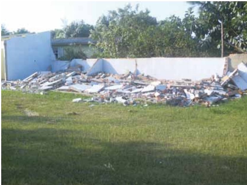
Paredes são derrubadas e dá-se início à concretização do sonho
